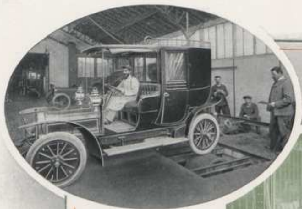
Rouleau d'essai des Voitures.
